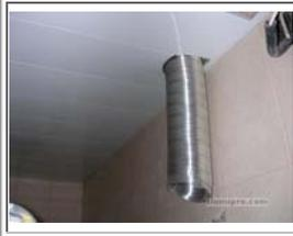
Prepare el corte del contorno de caída del tubo antes de colocar la lama. Puede hacer el agujero de forma similar a como se indicaba para cortar las lamas.
