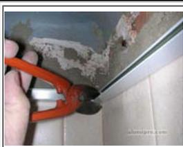
Para preparar el inglete interior bastará con cortar en diagonal sobre los dos perfiles superpuestos con una tijera de chapa.
