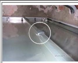
Siga colocando lamas uniéndolo cada una de las recién colocadas con la anterior mediante un clip metálico con una separación de un metro entre un clip y otro.
