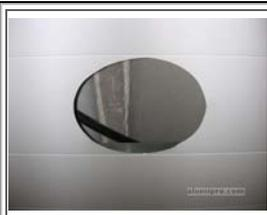
Haga un pequeño agujero con la punta de las tijeras o con un destornillador afilado y recorte el contorno con las tijeras. Las luminarias de techo suelen tener bastante margen para cubrir posibles errores de corte.
