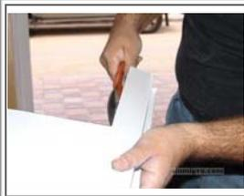
Corte la esquina de la misma manera que antes: usando una tijera de chapa nueva o que sólo haya cortado aluminio. Las tijeras que han cortado chapa de acero no cortarán con la misma facilidad.
