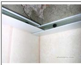
Monte en las esquinas un perfil dentro del otro, forzándolos ligeramente para facilitar el corte del inglete.
