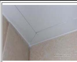
Limpie el exceso de silicona mediante un útil adecuado que podrá encontrar en cualquier ferretería o con los dedos humedecidos en agua jabonosa.
