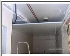
Siga colocando lamas en el techo hasta llegar al otro extremo. Si debe corregir la anchura de la última lama proceda a cortarla como se indicó anteriormente.
