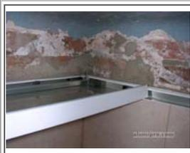
Una vez asentada la primera lama coloque los clips de fijación adecuados usando 2 clips de plástico en cada lado de la lama.
