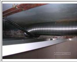
Los tubos de salida de gases o ventilación los debe ir colocando sobre las lamas hasta llegar al punto de salida.
